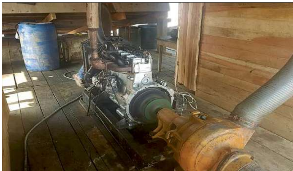
Foto 15 Motor MWM de 4 cilindros con acople de balatas para bomba de draga 6 x 6 (2019).
