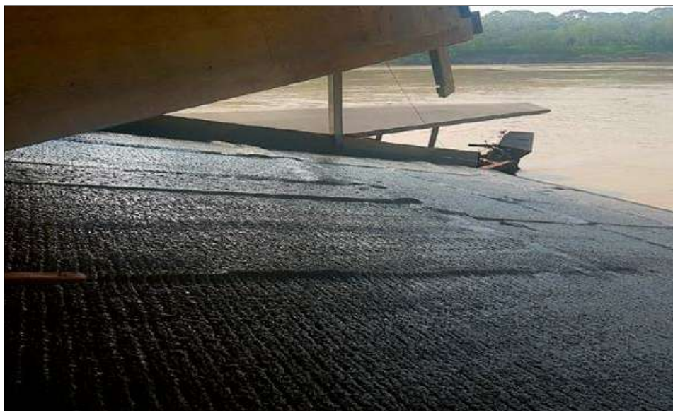
Foto 19 Alfombras de canaleta principal en balsa, Beni (2019).
