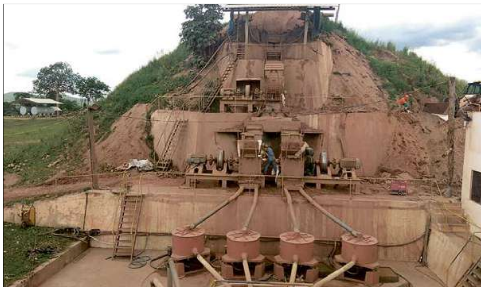
Foto 7 Planta de concentración gravimétrica San Ramón-Santa Cruz (2019).
